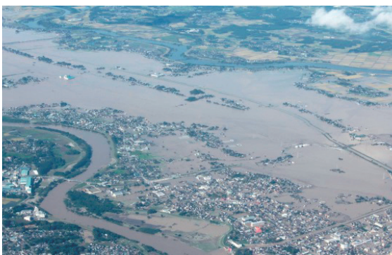
平成27年9月の台風18号等による浸水被害 (茨城県常総市)
